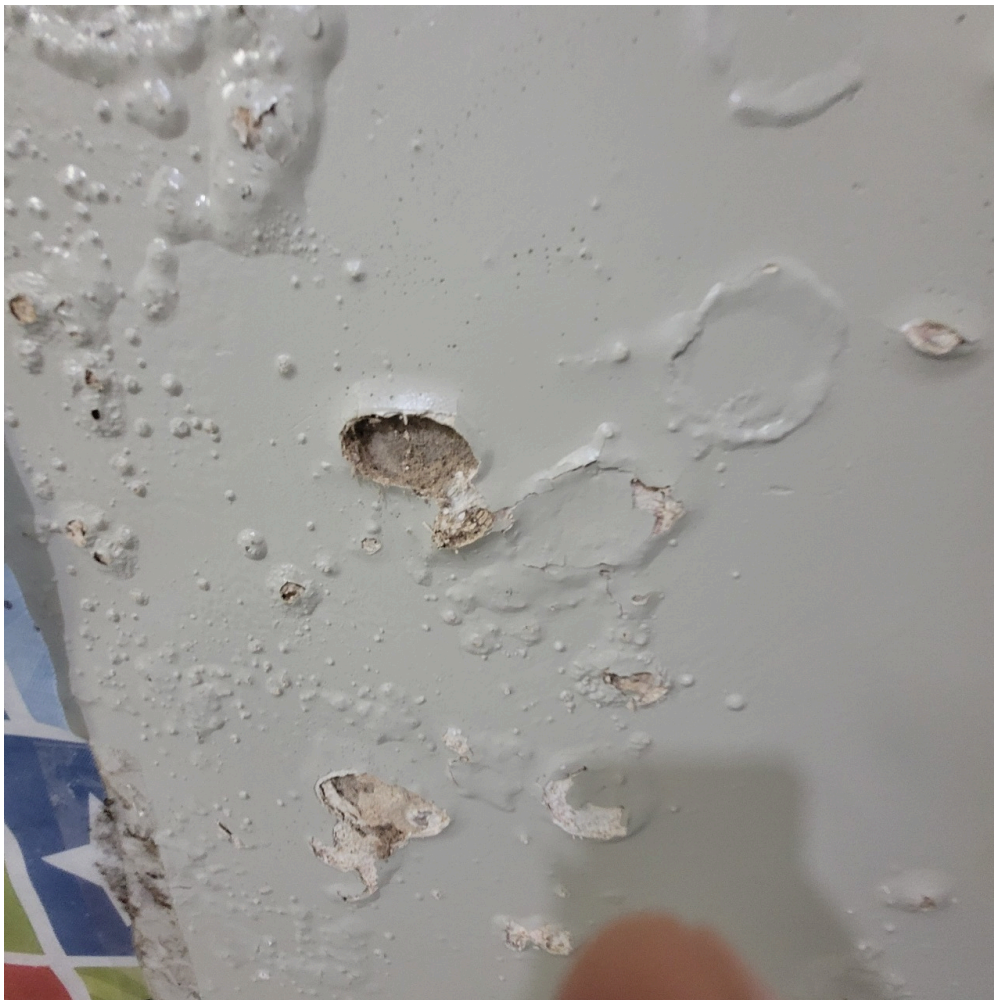
infiltração em parede de sala de vacinação que não é lavável
