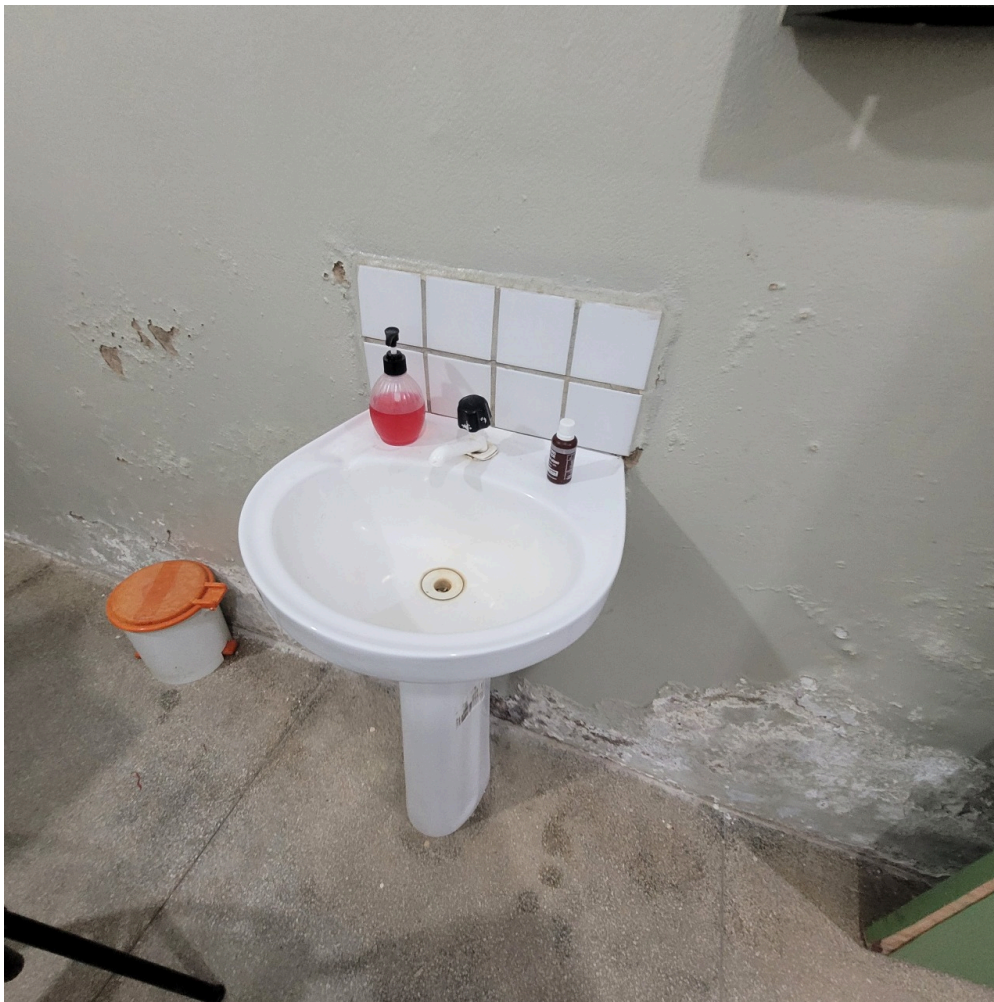
pia no consultório médico com infiltrações e mofo na parede
