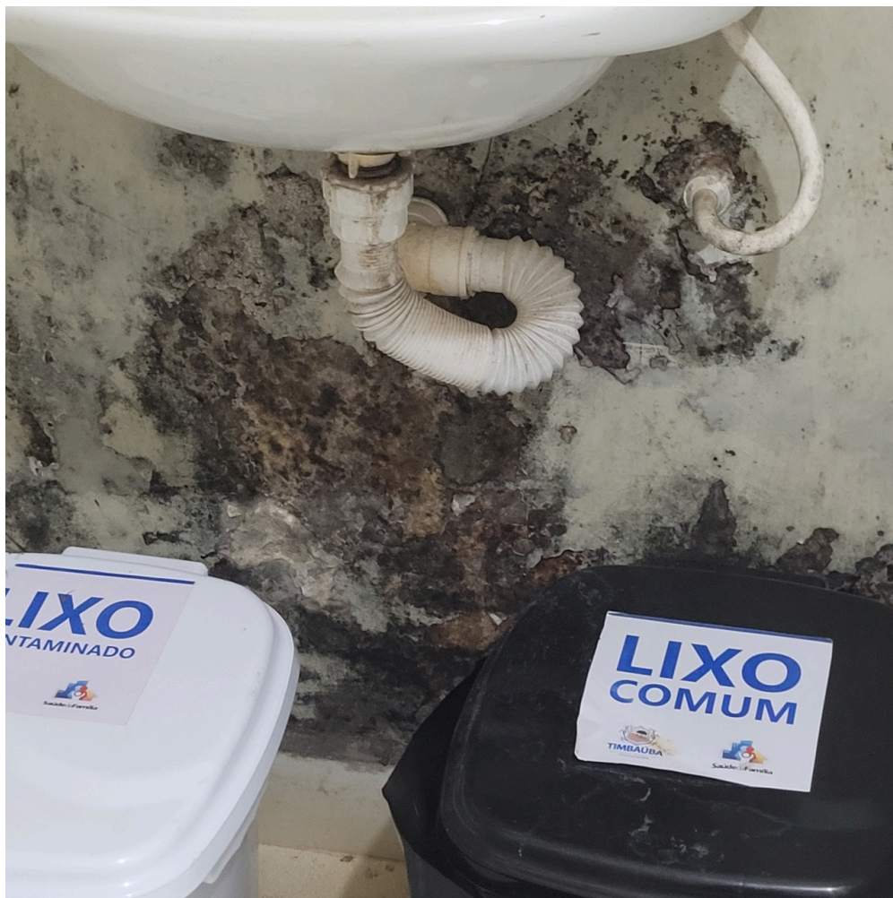
infiltração e mofo sob a pia na sala de vacinas
