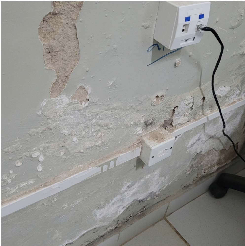
infiltração na parede próximo a pia e tomada elétrica no consultório de enfermagem
