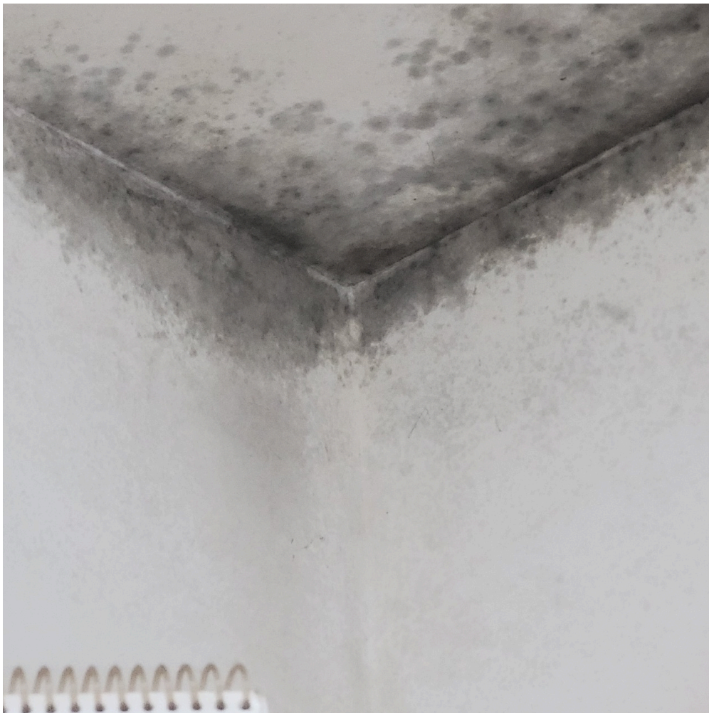
infiltração e mofo em teto e parede da sala de atendimento de enfermagem que não é climatizada
