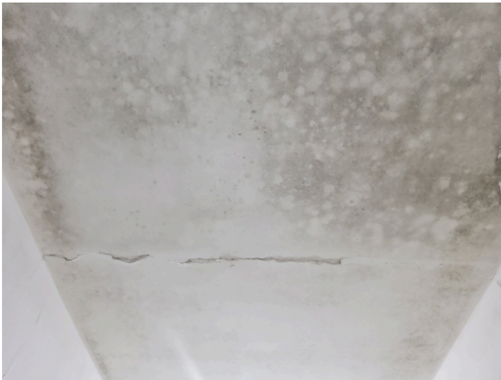
Infiltração e rachadura no teto
