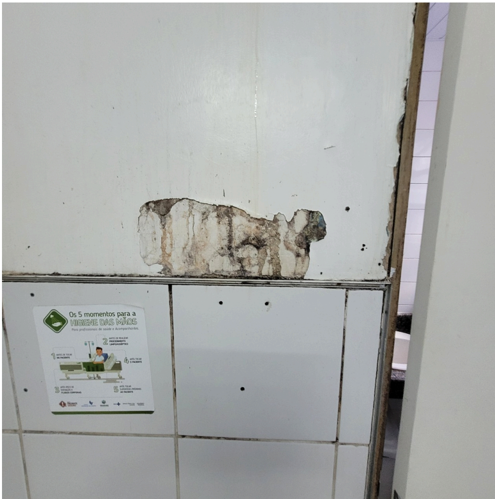
infiltração em parede da sala vermelha do SPA SRAG
