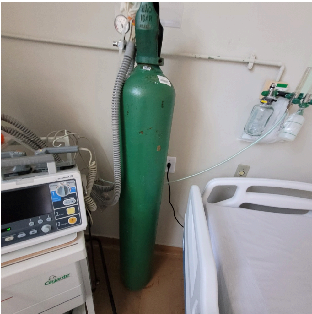
cilindro de oxigênio da sala vermelha de Pediatria sem fixação em carrinho ou corrente
