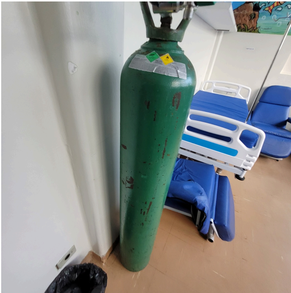
cilindro de oxigênio sem fixação na sala de observação pediátrica
