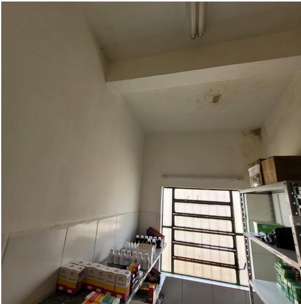
farmácia sem climatização com áreas de infiltração e mofo
