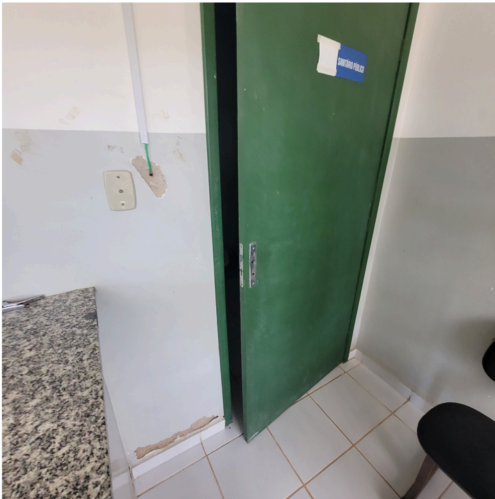
banheiro público na recepção com fechadura danificada
