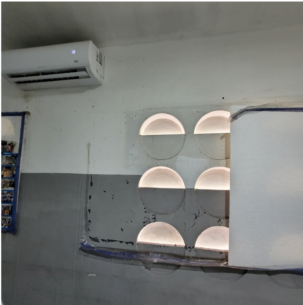
sala dos agentes comunitários de saúde com isolamento térmico precário feito por isopor, ausente em alguns cobogós
