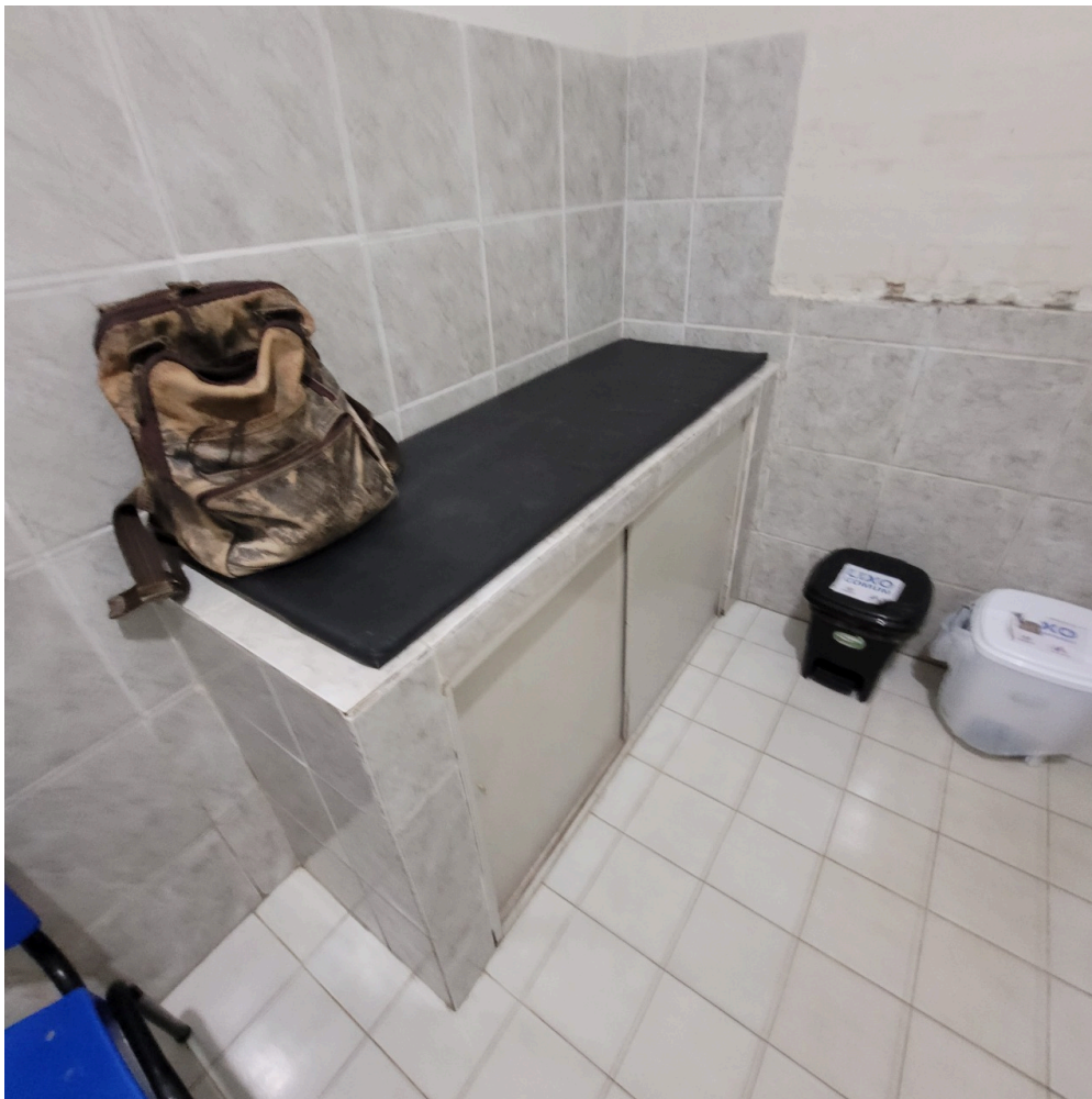
maca fixa da sala de vacinação com destaque para meia parede infiltrada
