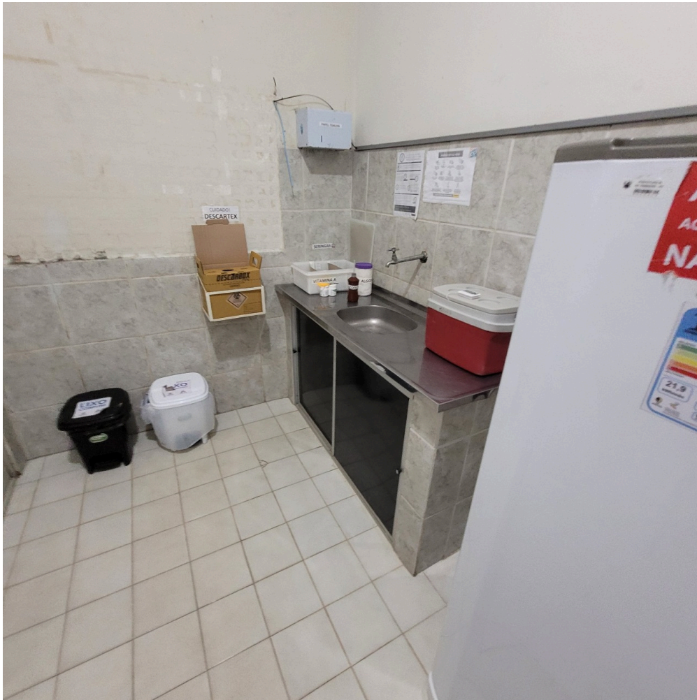
sala de vacinação com meia parede lavável, infiltrações e mofo em parte da parede sem impermeabilização
