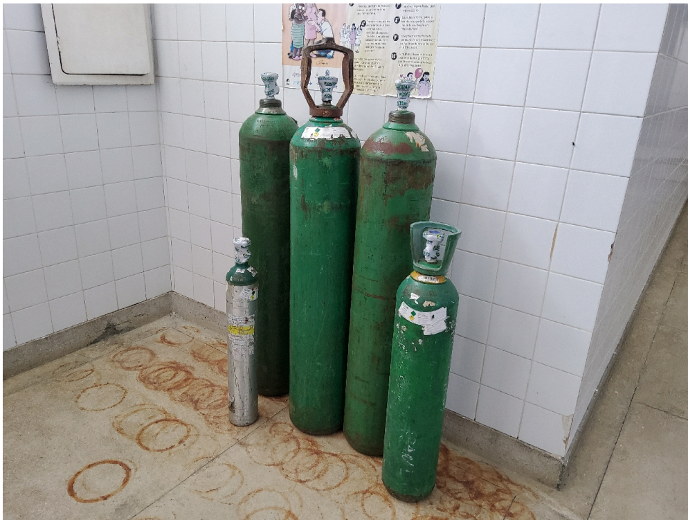
Cilindros de oxigênio sem fixação no corredor da unidade
