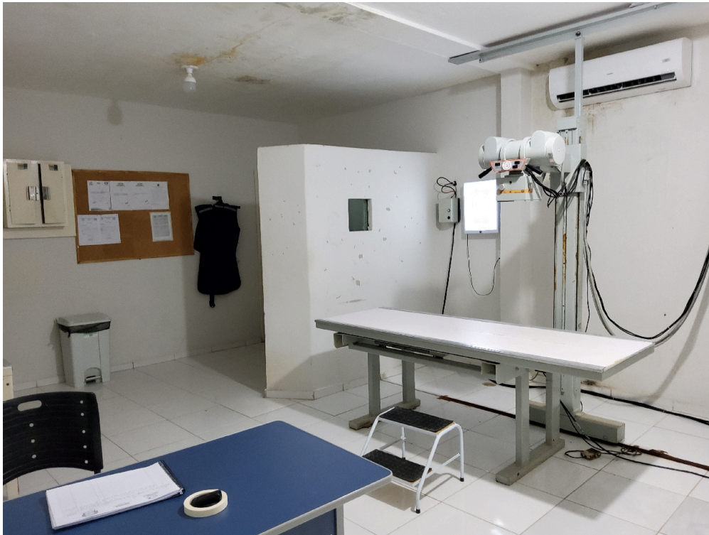
Sala de RX - observar infiltração
