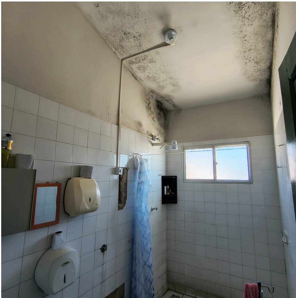
infiltrações e mofo no teto e parede de banheiro no repouso médico
