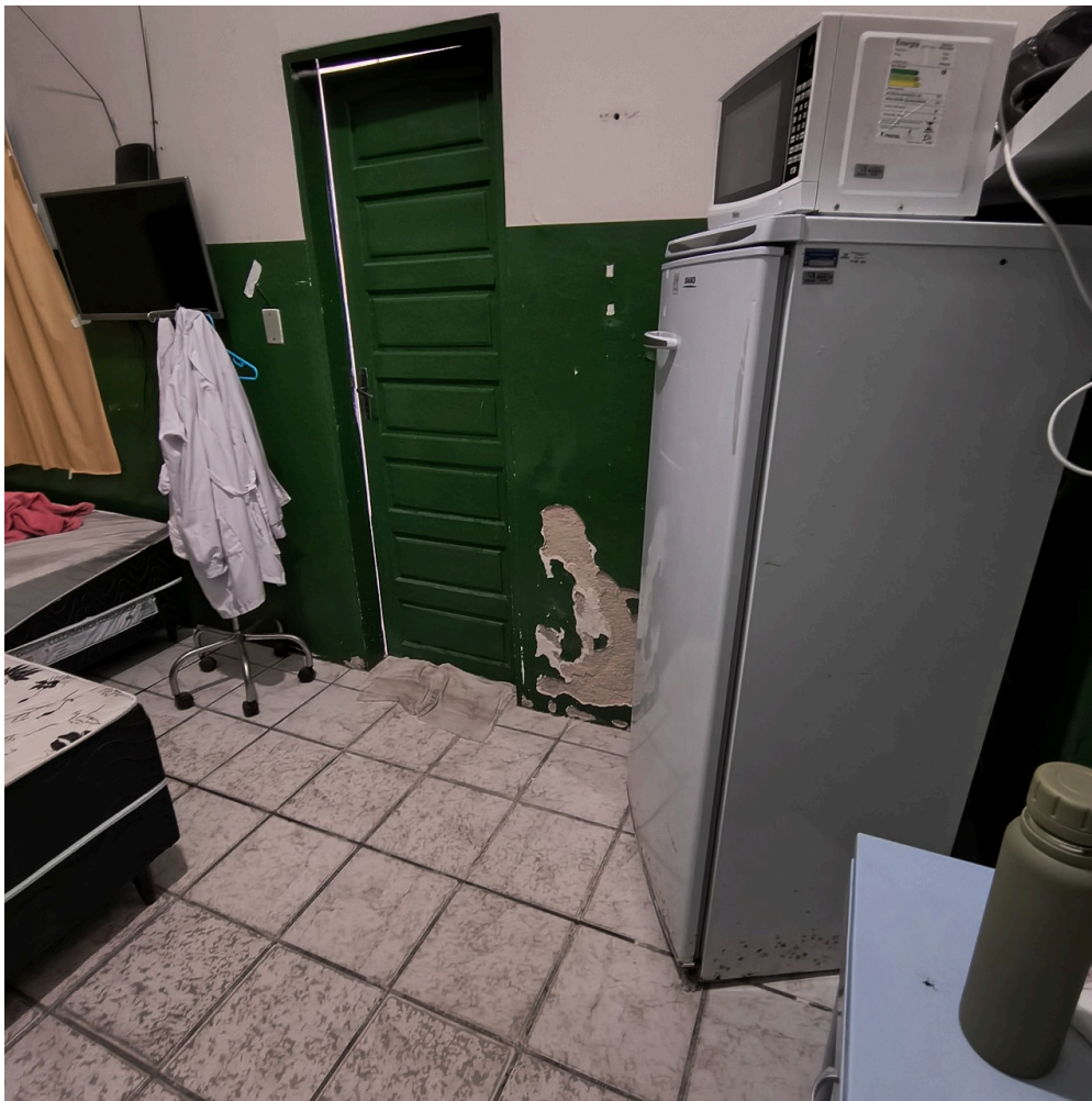
repouso médico com infiltrações e mofo na parede
