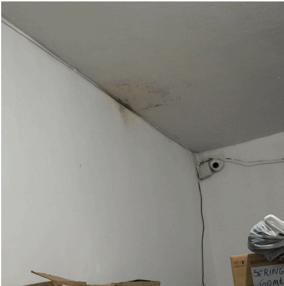
infiltrações e mofo na farmácia hospitalar
