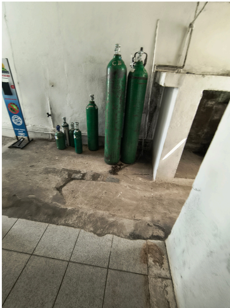
cilindros de oxigênio sem fixação
