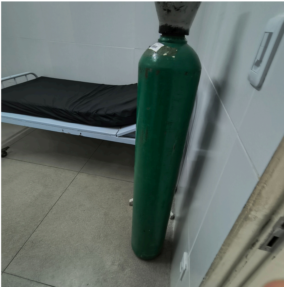
cilindro de oxigênio no repouso SEM fixação
