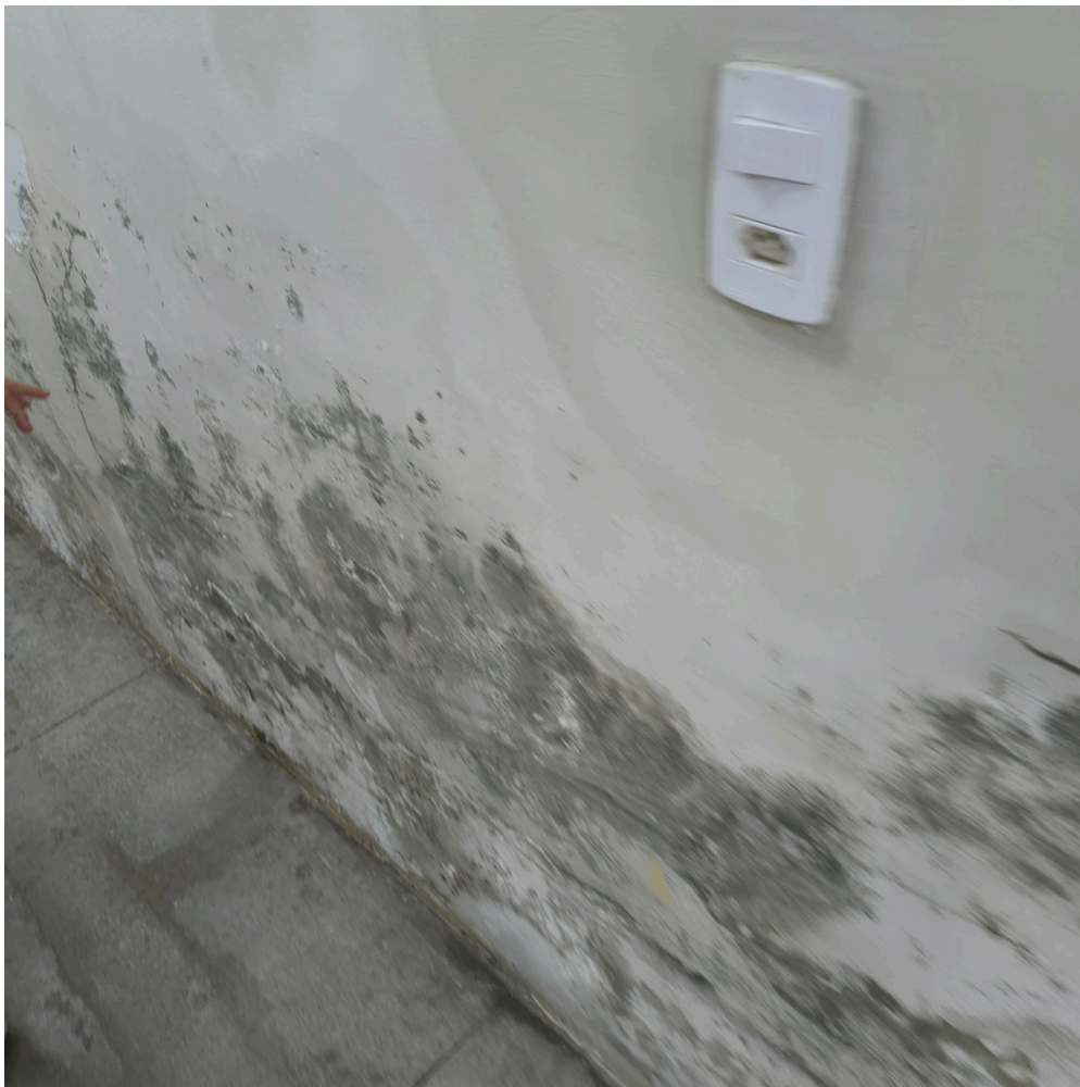
infiltrações e mofo em corredor
