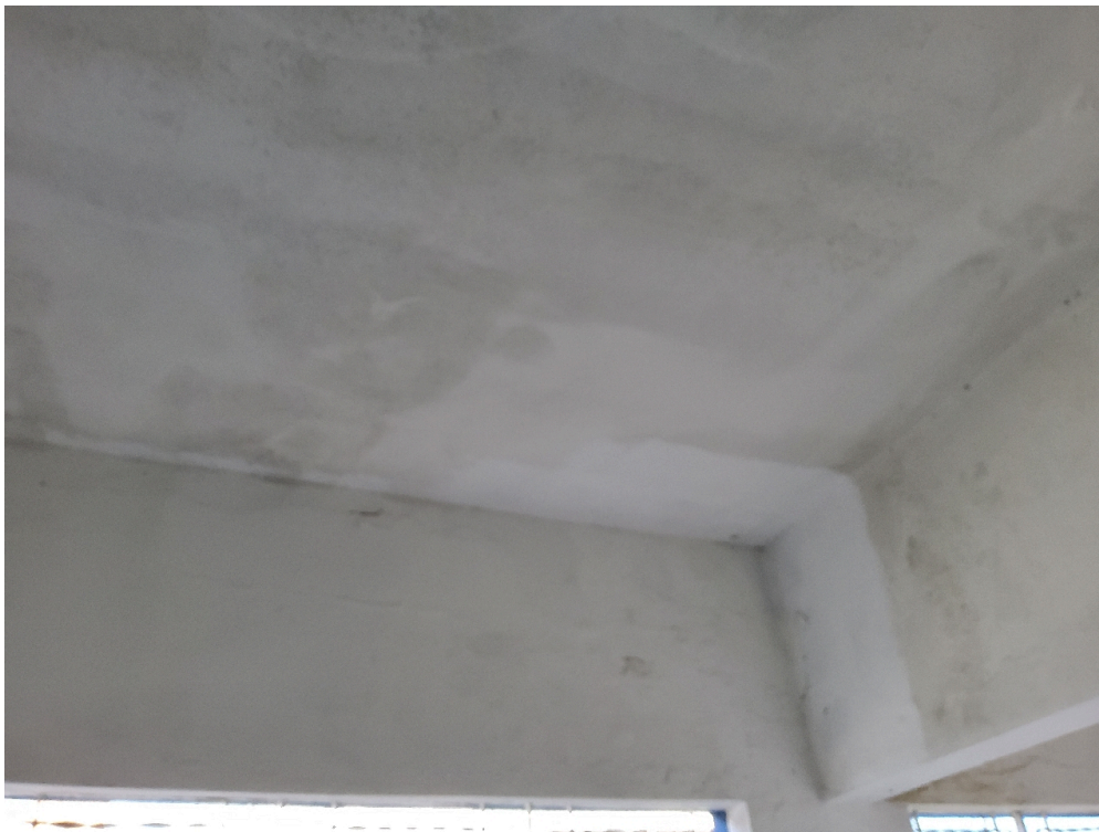
Infiltração (foto 1)
