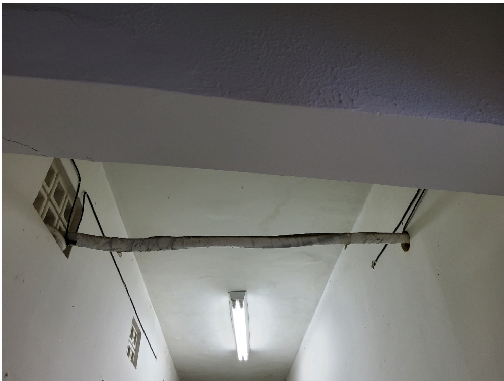
Tubulação do ar-condicionado
