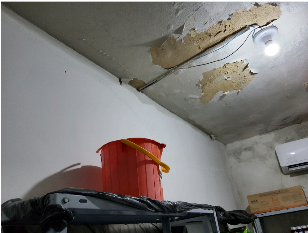
Farmácia (foto 1) - observar balde para apapar água das goteiras
