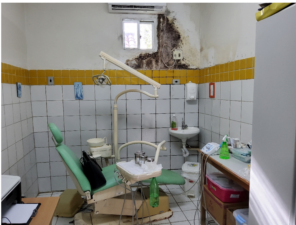
Sala do dentista (foto 1) - observar infiltração
