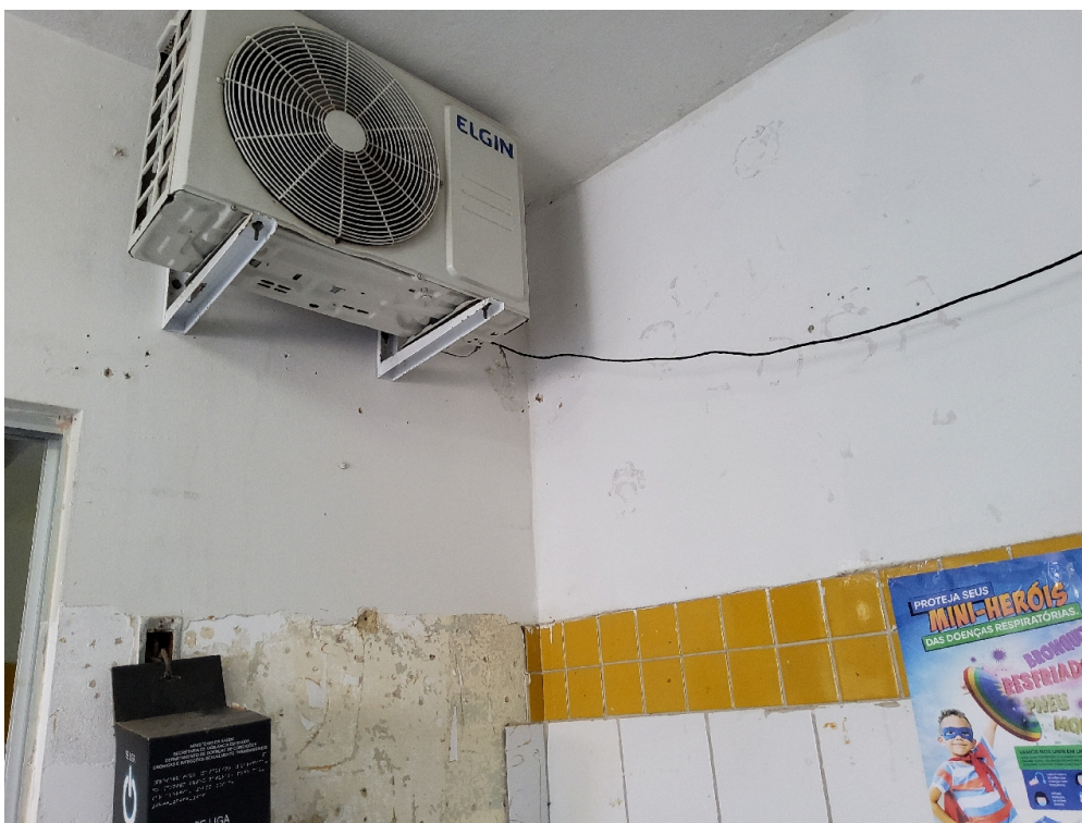
Infiltração e reboco caindo
