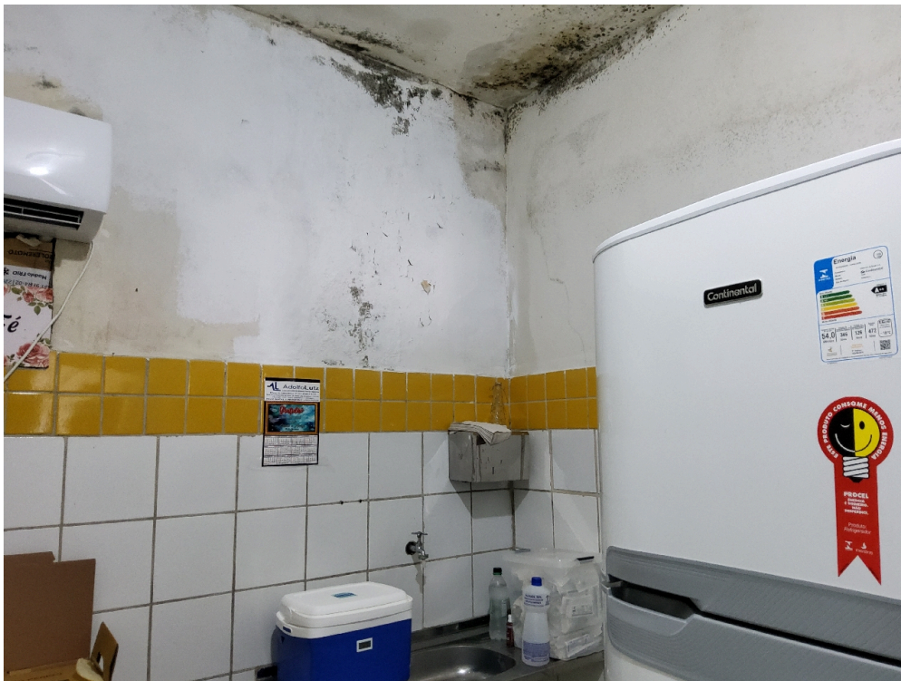
Sala de vacina (observar infiltração)
