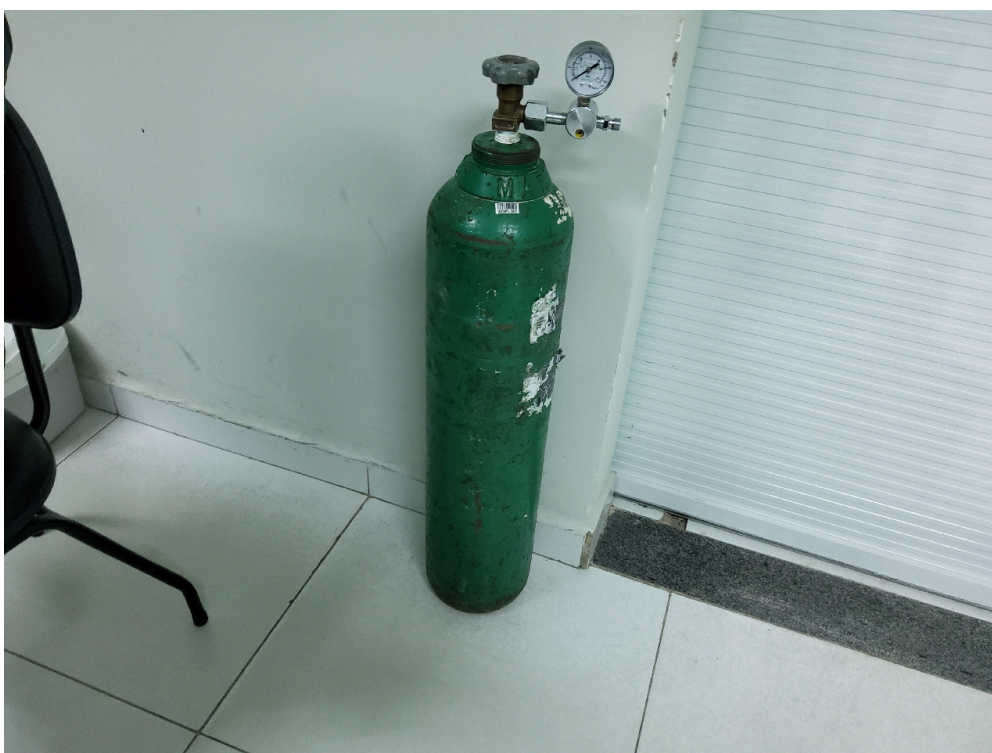
Torpedo de oxigênio sem fixação
