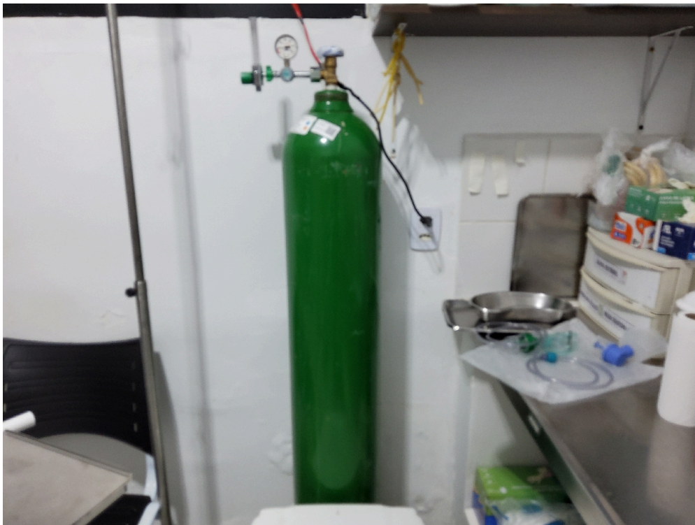
Torpedo de oxigênio sem fixação
