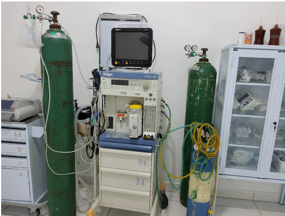
Sala de cirurgia (foto 2) - torpedos de oxigênio sem fixação
