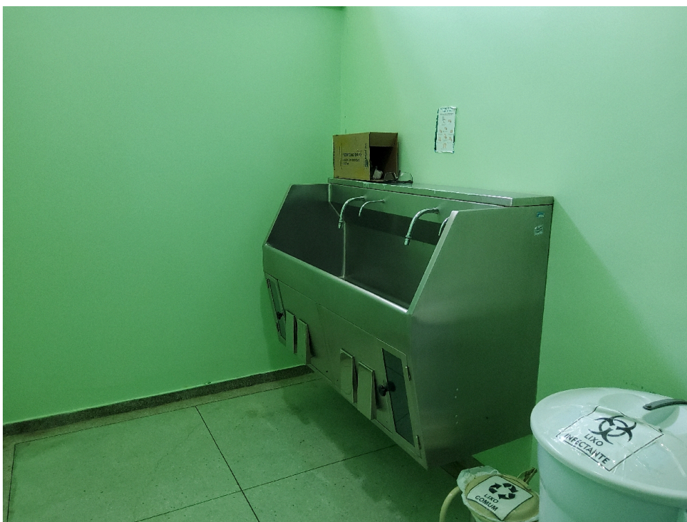
Lavabo do bloco cirúrgico
