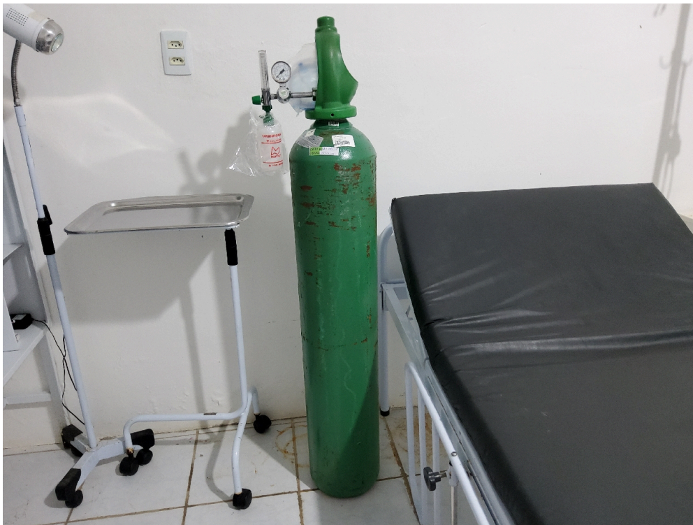
Cilindro de oxigênio não está fixo à parede ou em carrinho apropriado para armazenamento e transporte
