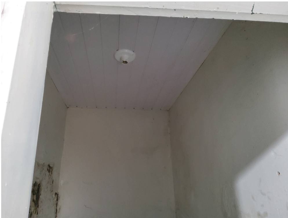
Local onde fica pia da sala de medicação (observar infiltração e ausência de lâmpada)
