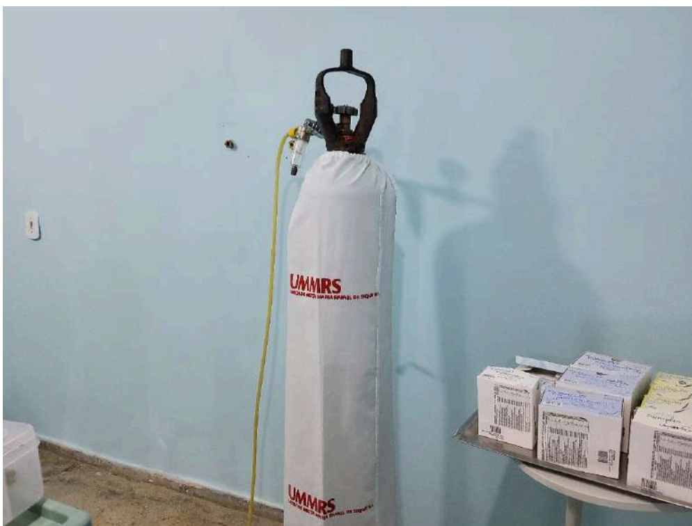
SALA CIRÚRGICA / EQUIPAMENTOS - cilindro de oxigênio sem fixação
