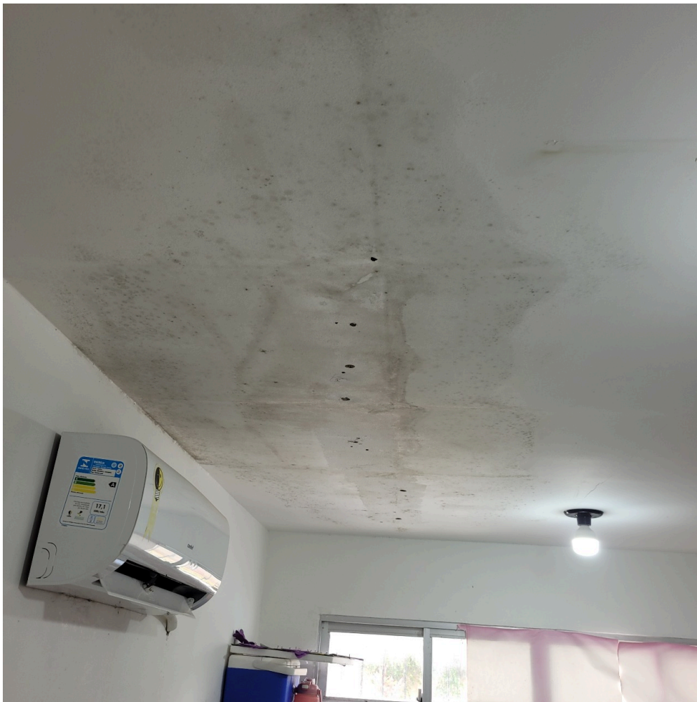
infiltrações no teto da sala de vacinas
