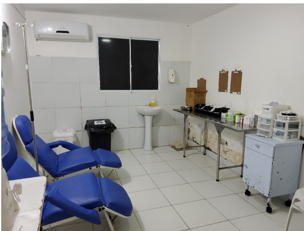
Sala de medicação (observar infiltração)
