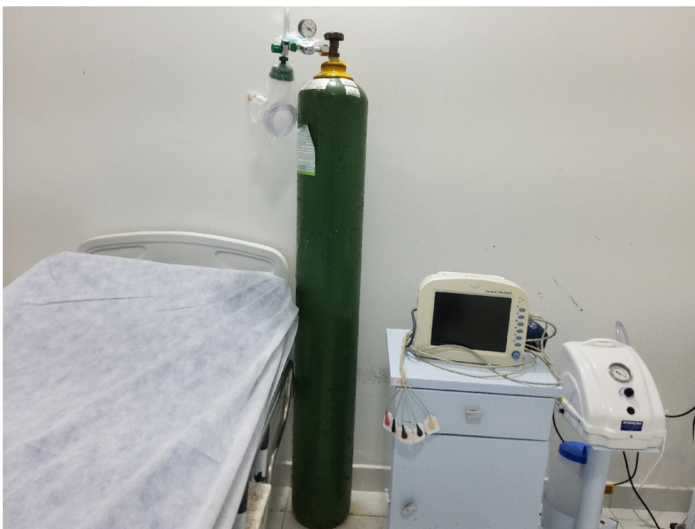
Cilindro de oxigênio sem fixação
