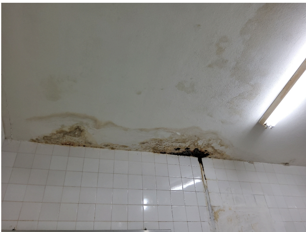
Infiltração na sala de parto
