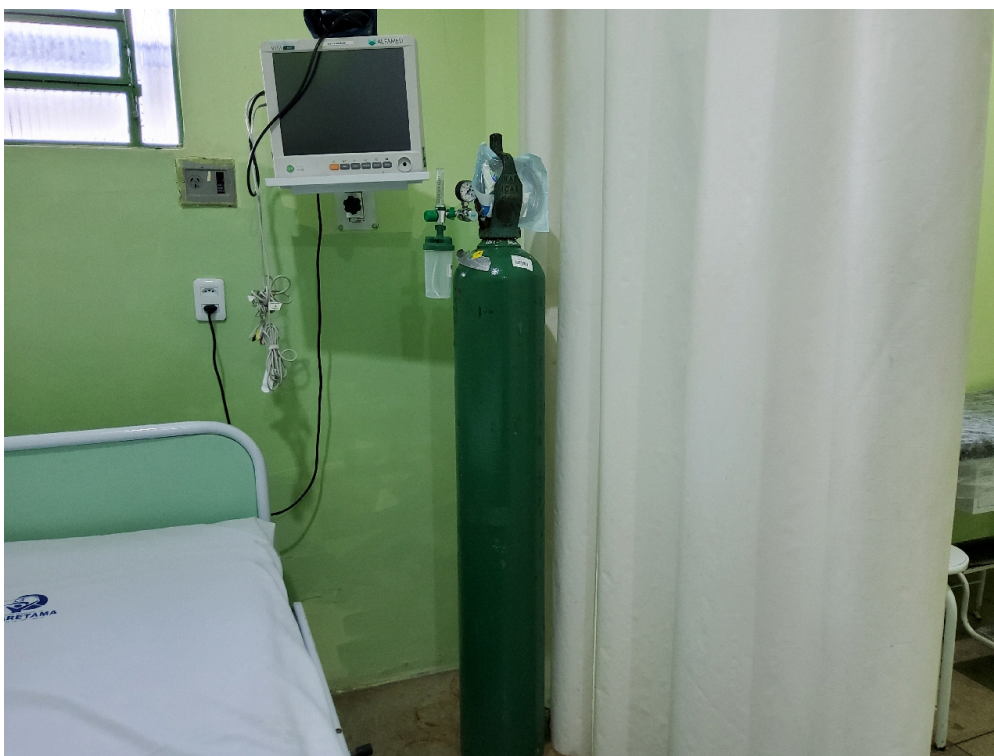
Item não conforme: Cilindro de oxigênio sem fixação
