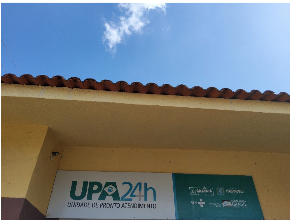
DADOS CADASTRAIS - Registro Fotográfico da Fachada
