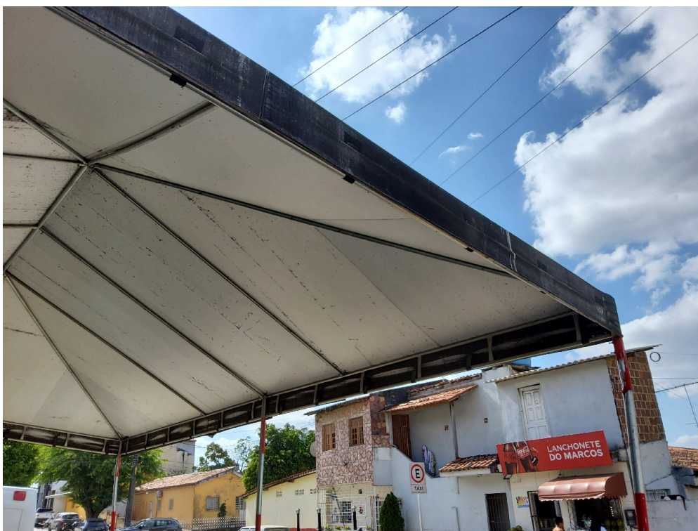
DADOS CADASTRAIS - Registro Fotográfico da Fachada
