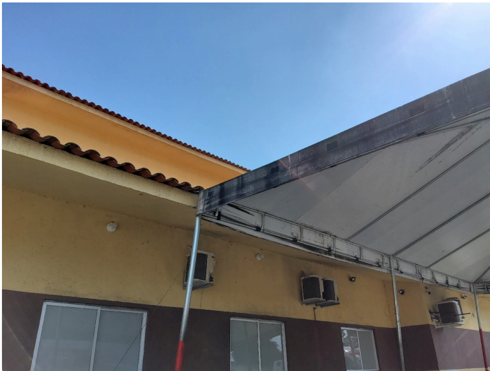
DADOS CADASTRAIS - Registro Fotográfico da Fachada
