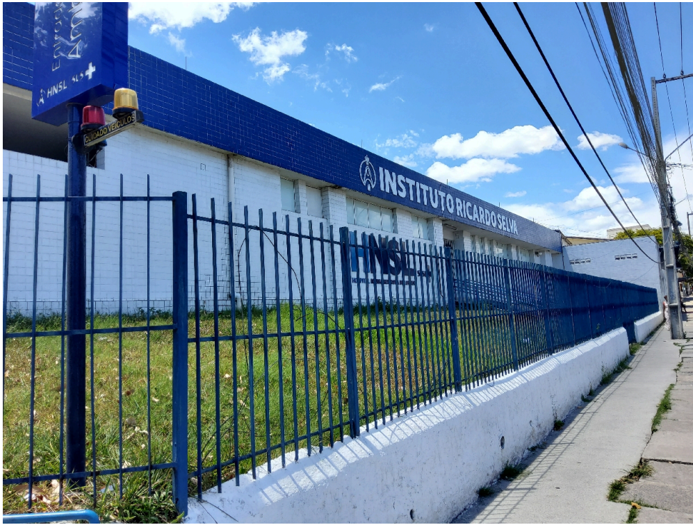
DADOS CADASTRAIS - Registro Fotográfico da Fachada
