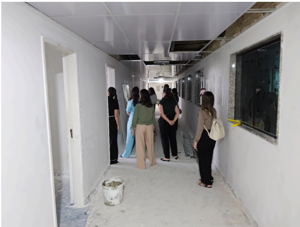
Imagem da 1ª constatação.
