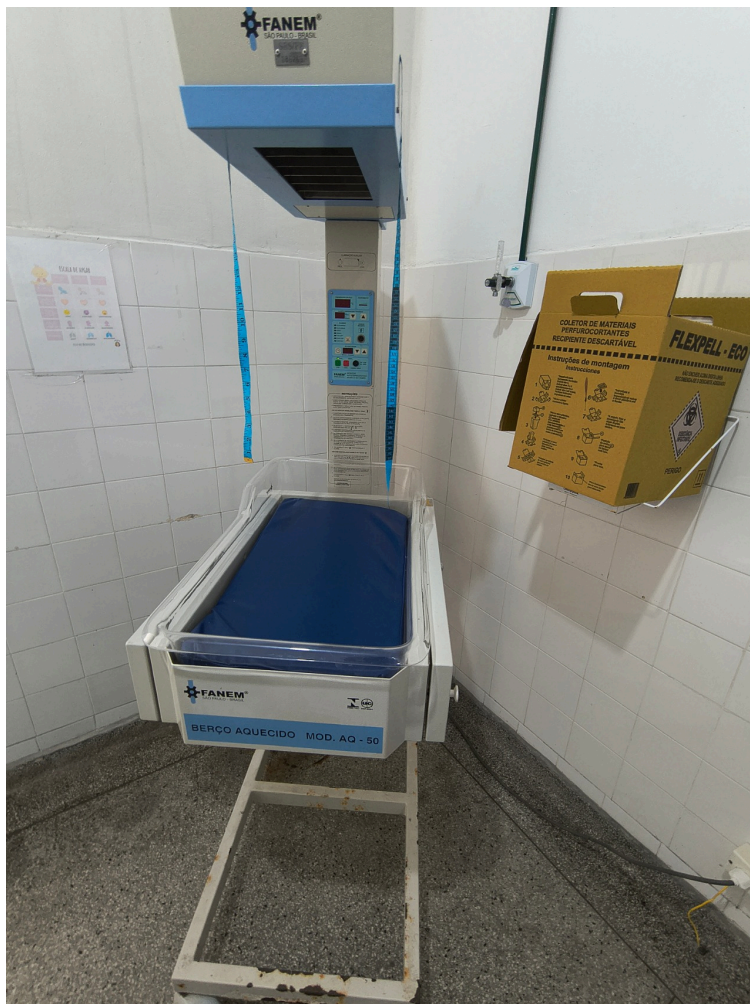
Berço aquecido e descartex na sala de parto
