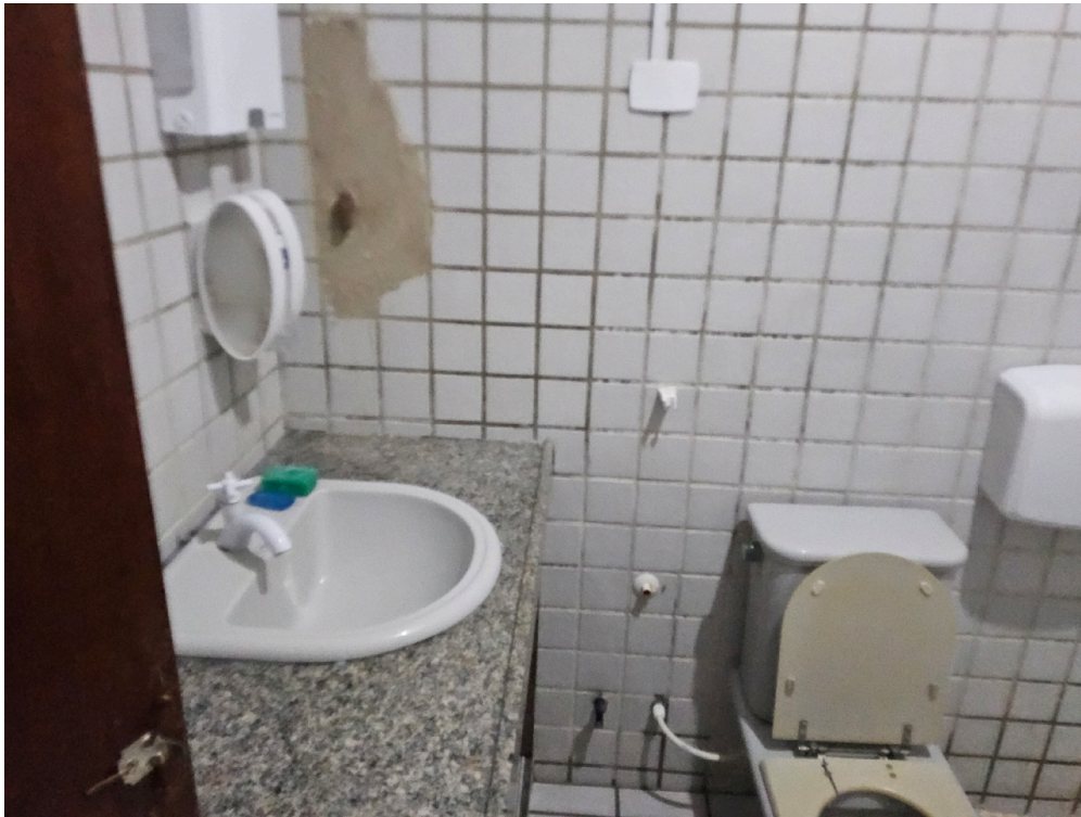
CONDIÇÕES ESTRUTURAIS DO AMBIENTE FÍSICO - GERAL - Sanitários para pacientes
