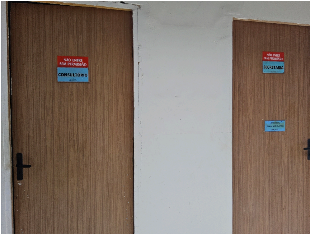
CONDIÇÕES ESTRUTURAIS DO AMBIENTE FÍSICO - GERAL - Sinalização de acessos
