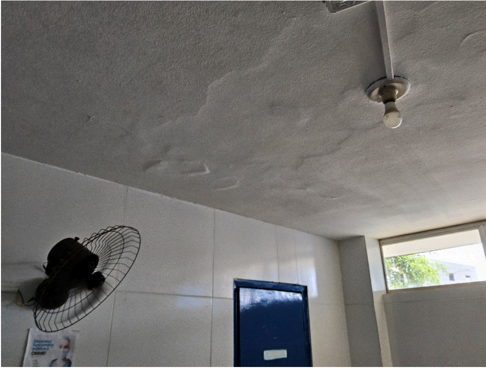
ESTRUTURA DA UNIDADE - Sala de Observação
