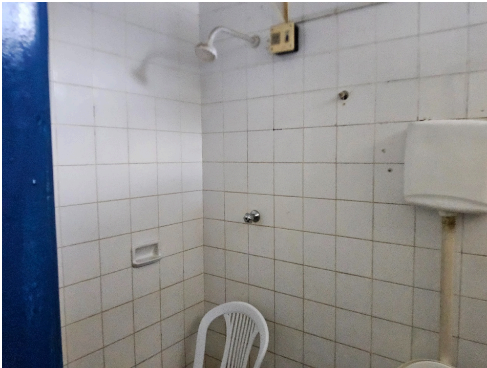
ESTRUTURA DA UNIDADE - Sala de Observação
