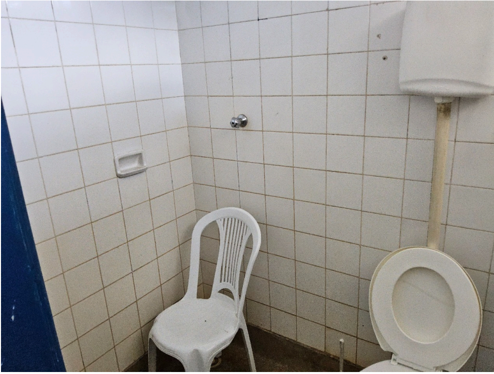
ESTRUTURA DA UNIDADE - Sala de Observação
