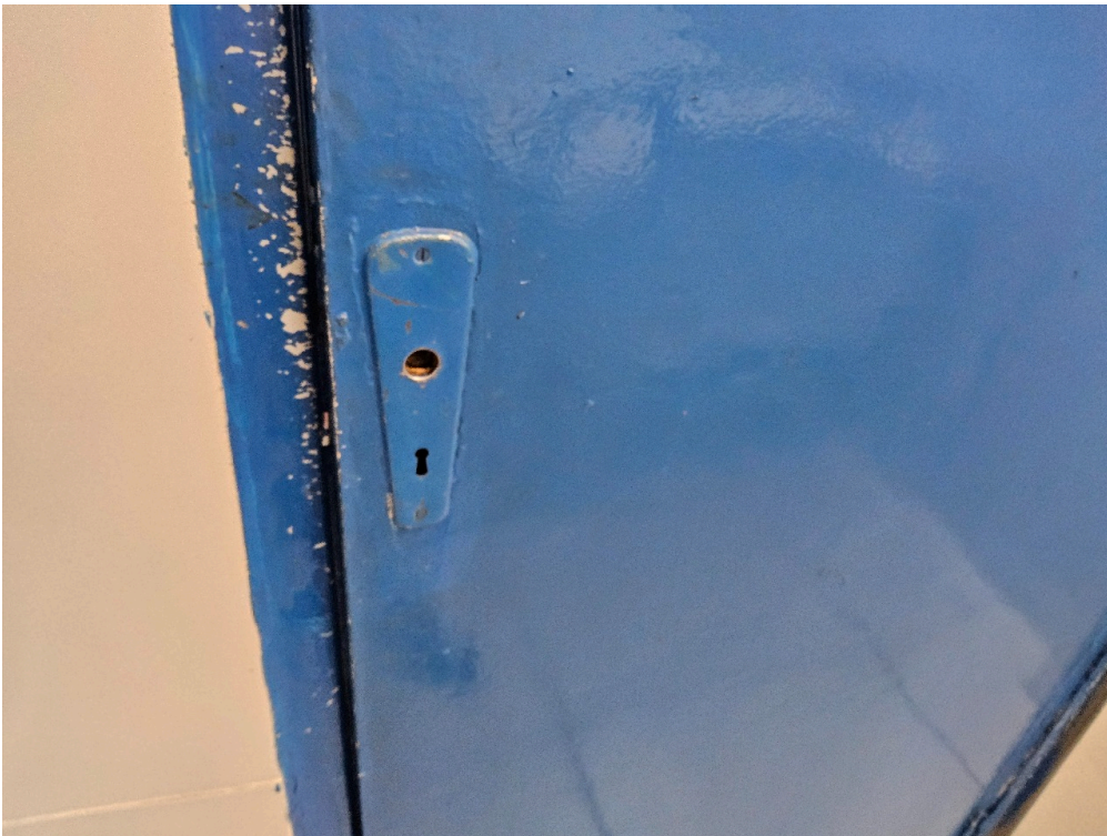
ESTRUTURA DA UNIDADE - Sala de Observação
