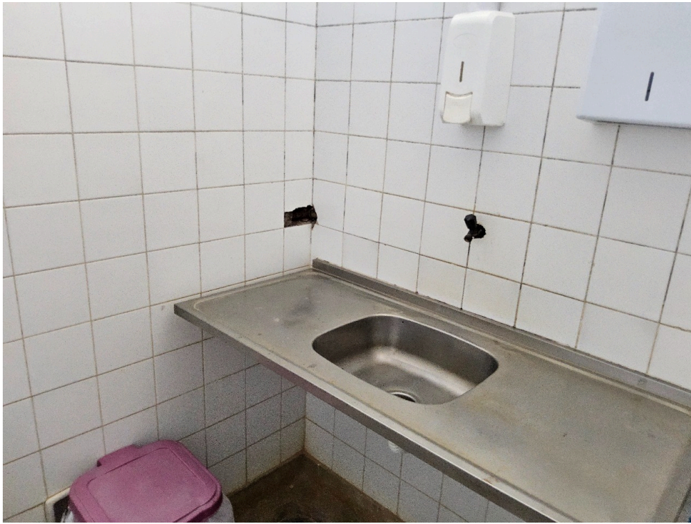
ESTRUTURA DA UNIDADE - Sala de Observação
