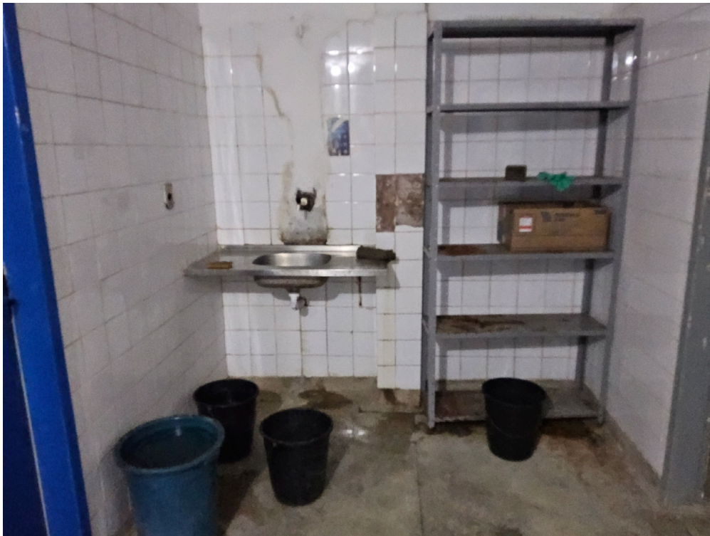
ATIVIDADES / SERVIÇOS HOSPITALARES (itens apenas informativos) - Centro de parto normal
