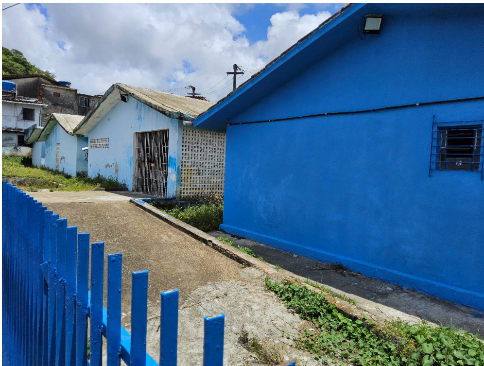
Imagem da 3ª constatação.
