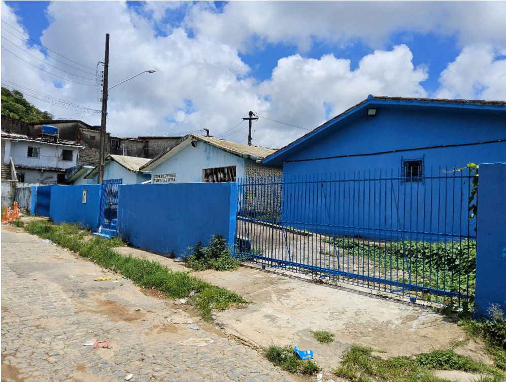
Imagem da 3ª constatação.
