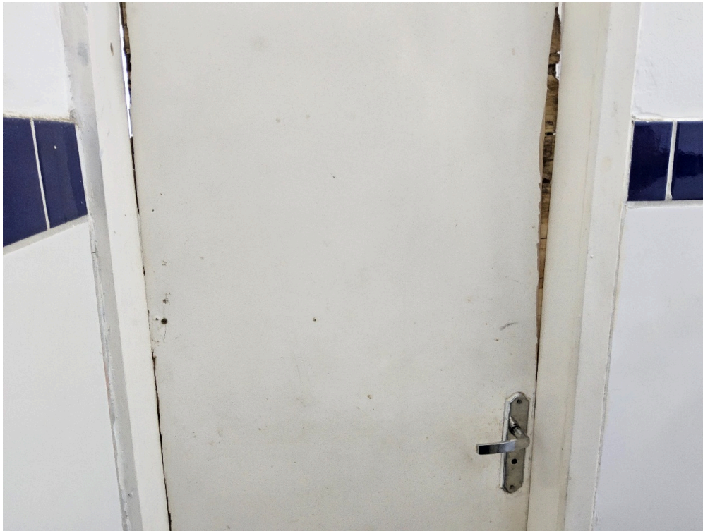
Consultório GINECOLOGIA E OBSTETRÍCIA - grupo 2 # Ginecologia - Sanitário
