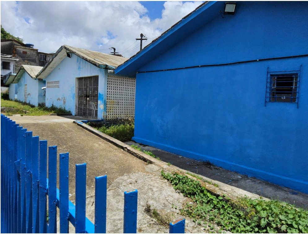
Imagem da 3ª constatação.
