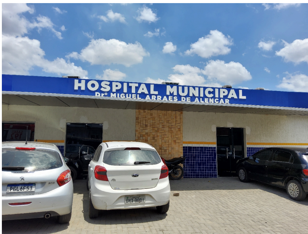
DADOS CADASTRAIS - Registro Fotográfico da Fachada
