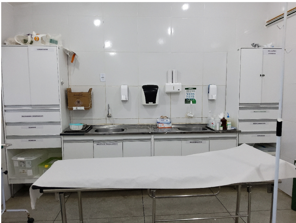
SALA DE REANIMAÇÃO E ESTABILIZAÇÃO DE PACIENTES GRAVES (SALA DE URGÊNCIA, EMERGÊNCIA OU VERMELHA) – ADULTO - Pia com água corrente
