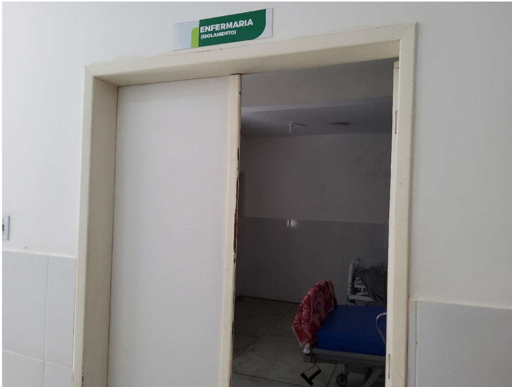
QUARTO DE ISOLAMENTO - sem antecâmara de acesso ao quarto de isolamento
