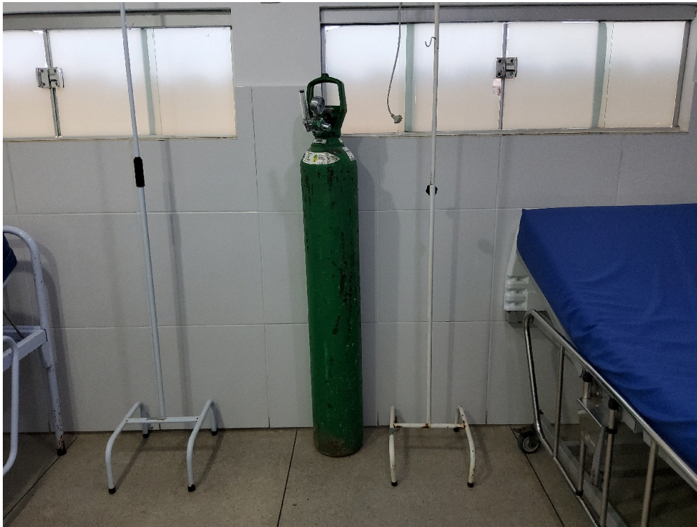
Cilindro de oxigênio sem fixação
