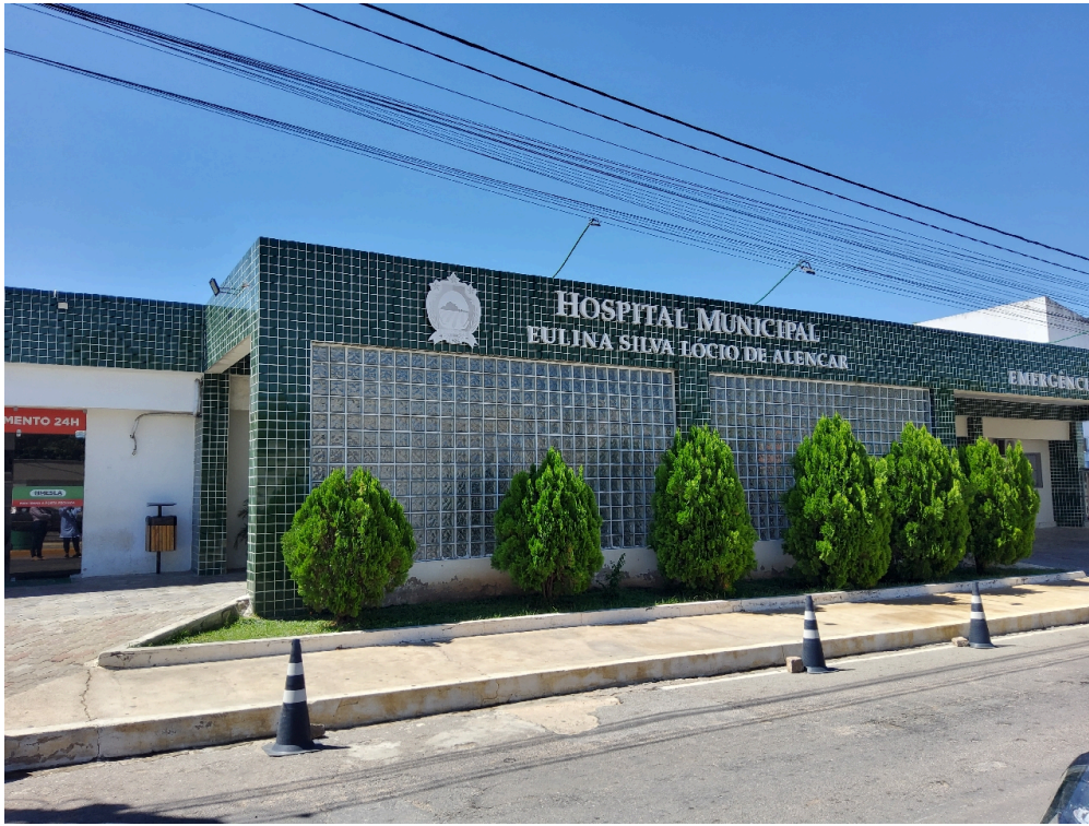
DADOS CADASTRAIS - Registro Fotográfico da Fachada
