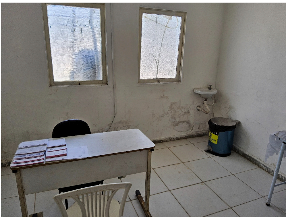
Imagem da 3ª constatação.
