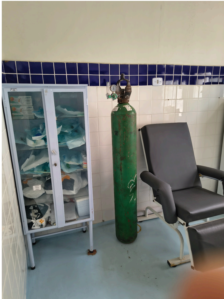
sala de nebulização com uma poltrona e cilindro de oxigênio sem fixação em corrente ou carrinho
