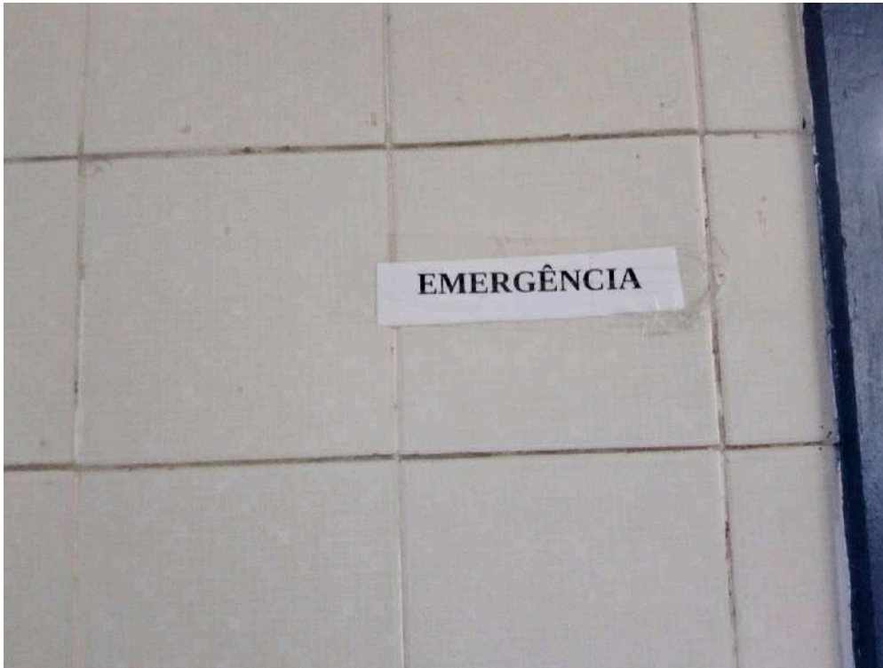
Imagem da 6ª constatação.
