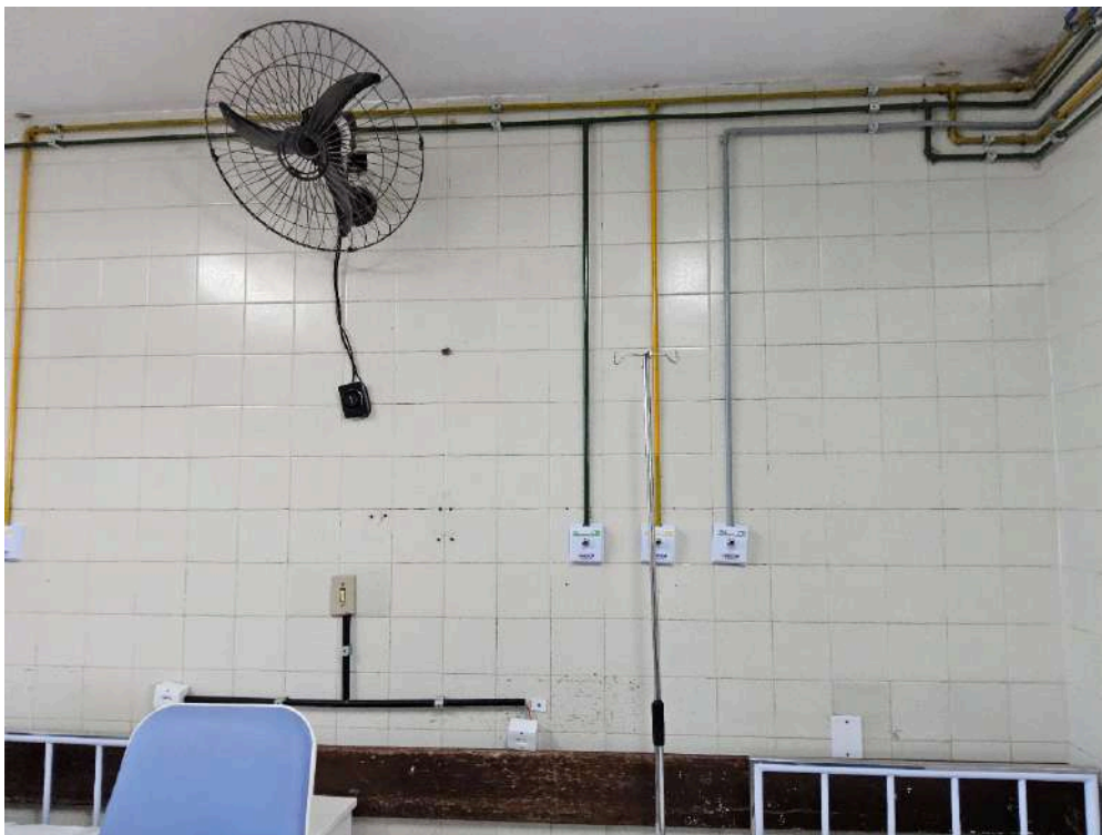
Imagem da 6ª constatação.
