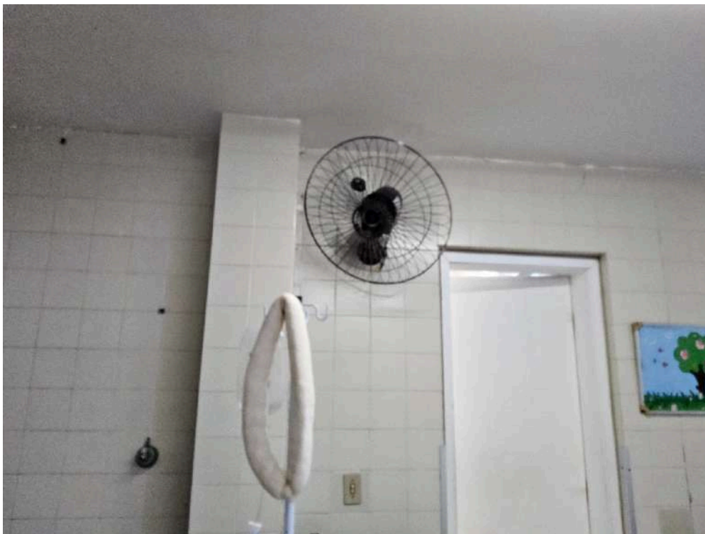
Imagem da 6ª constatação.
