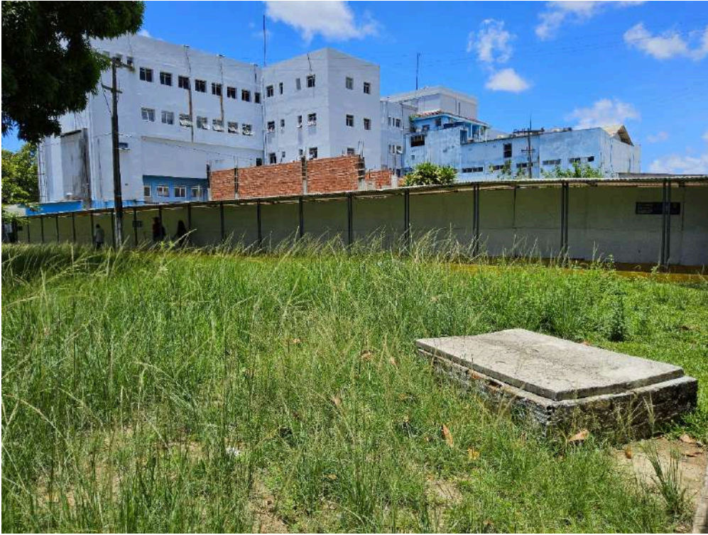
Imagem da 5ª constatação.
