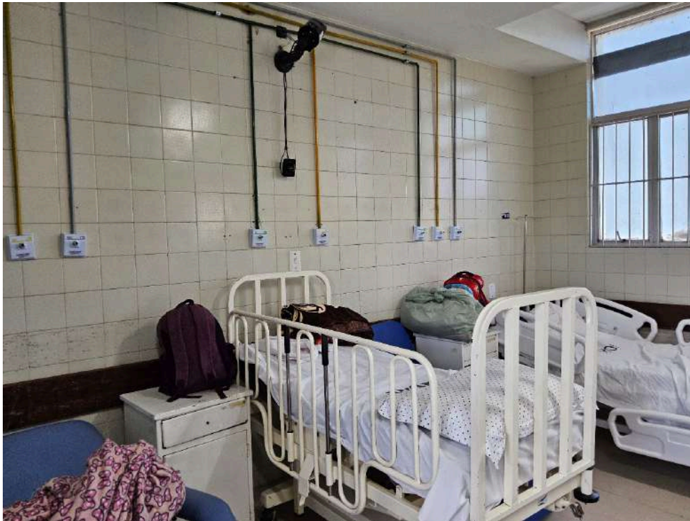
Imagem da 6ª constatação.
