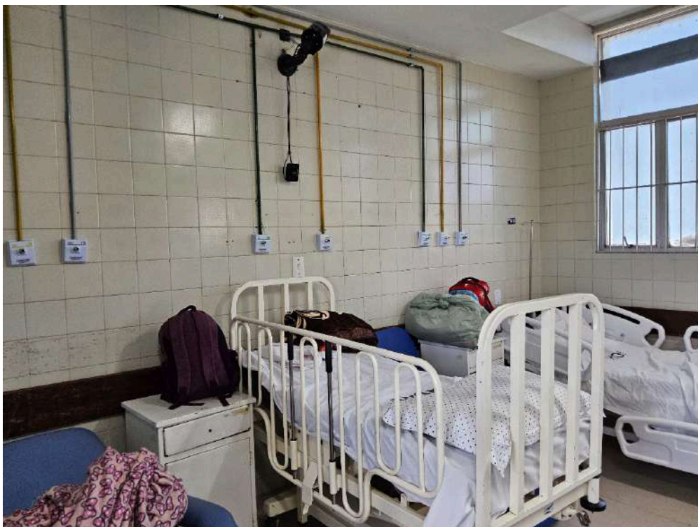
CONDIÇÕES ESTRUTURAIS DO AMBIENTE FÍSICO - GERAL - Instalações elétricas compatíveis com a segurança do paciente
