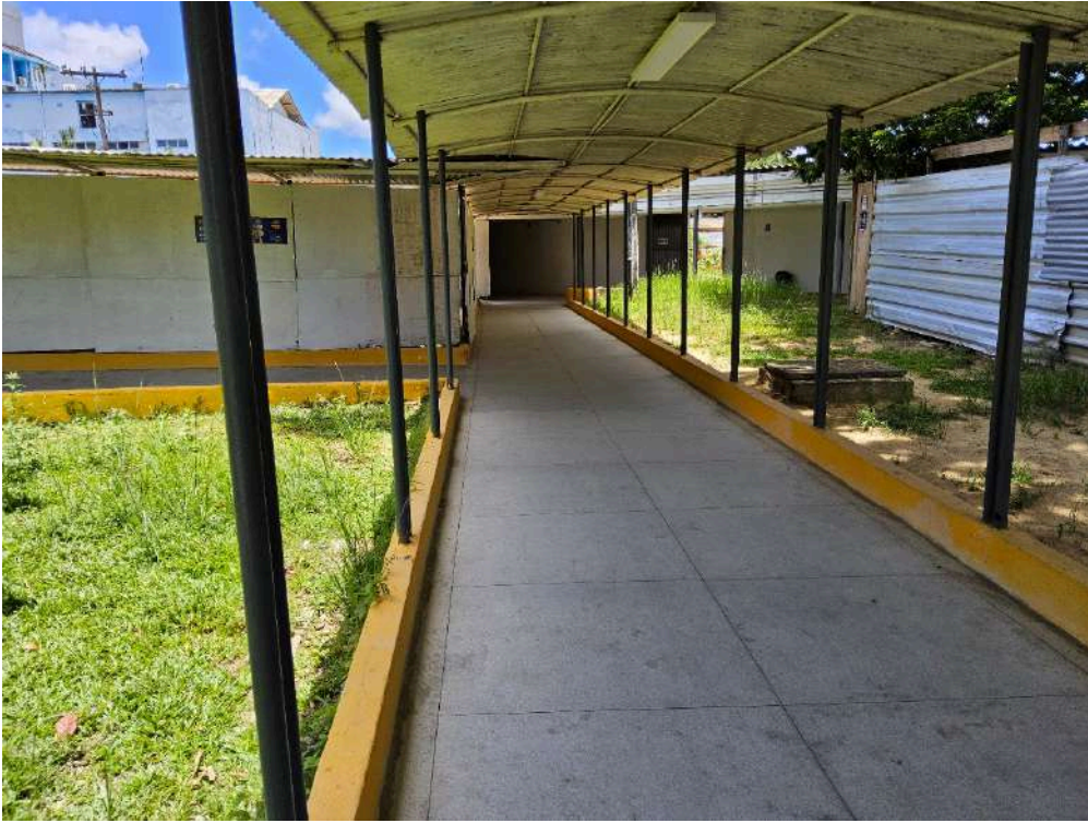
Imagem da 5ª constatação.
