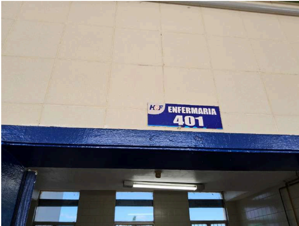
Imagem da 6ª constatação.
