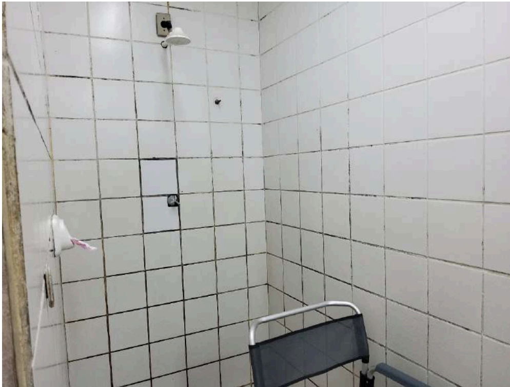
ATIVIDADES / SERVIÇOS HOSPITALARES (itens apenas informativos) - Unidade de internação. Enfermaria não reformada.
