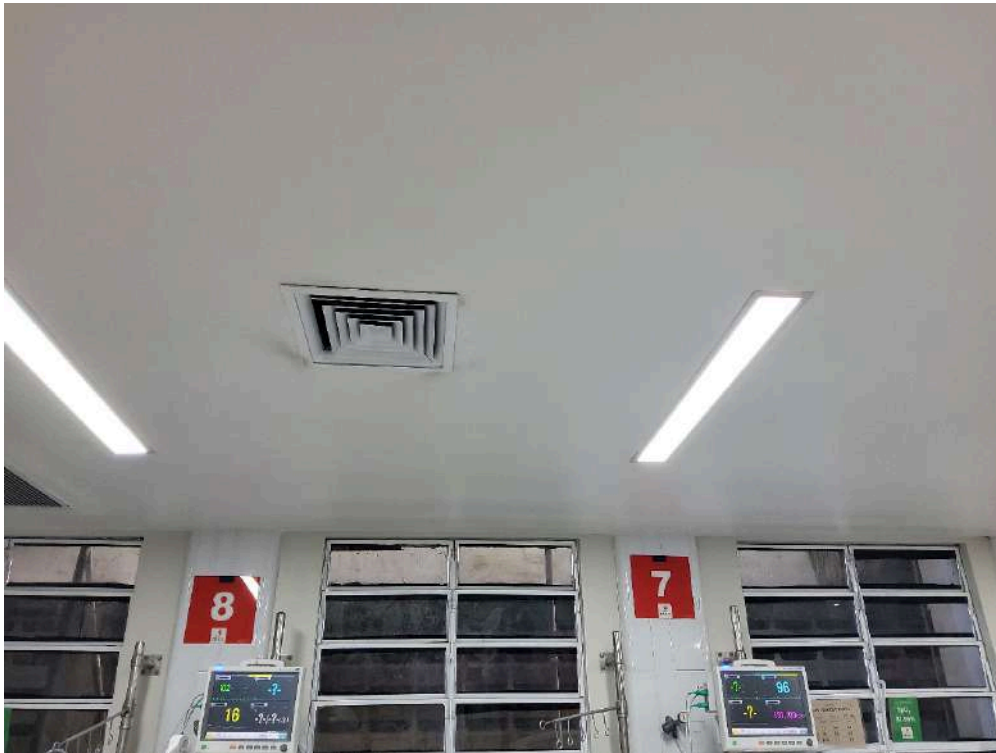
ATIVIDADES / SERVIÇOS HOSPITALARES (itens apenas informativos) - Unidade de Terapia Intensiva Pediátrica
