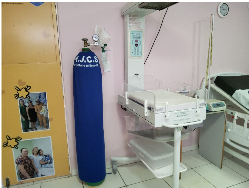
SALA DE PARTO (observar cilindro de oxigênio sem fixação)
