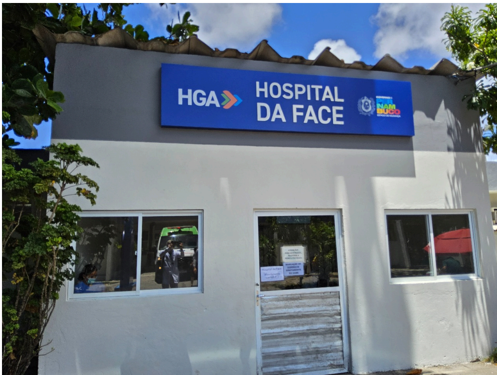
DADOS CADASTRAIS - Registro Fotográfico da Fachada
