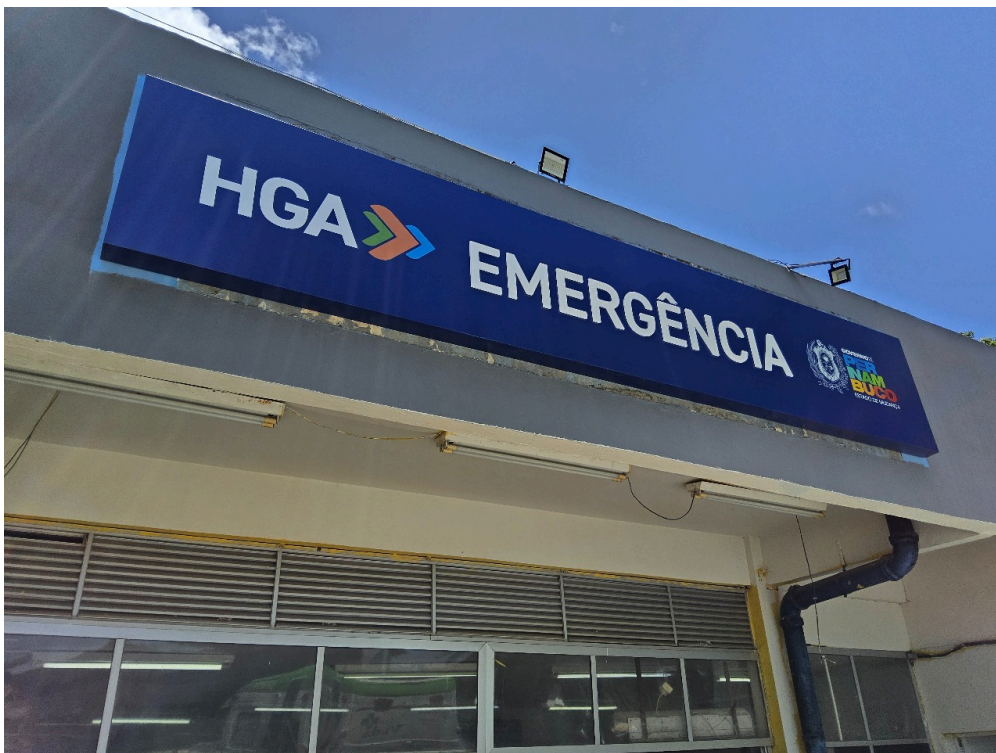
Entrada da emergência
