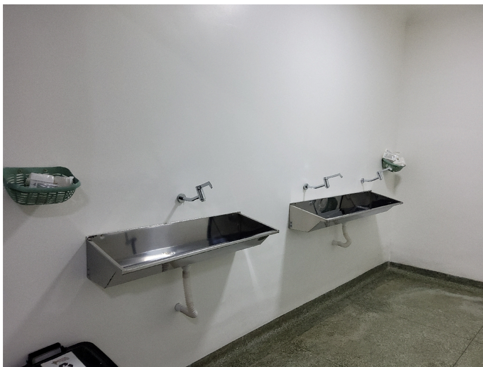
LAVABO DO BLOCO CIRÚRGICO
