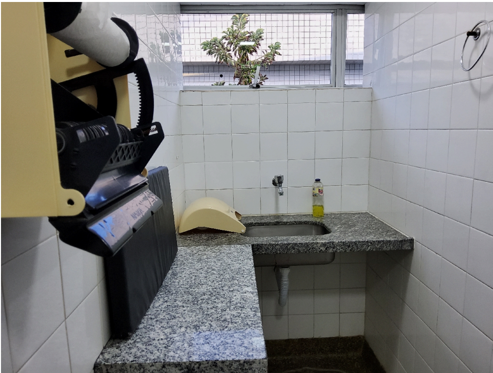
ATENDIMENTO OBSTÉTRICO - POSTO DE ENFERMAGEM # ATENDIMENTO OBSTETRICO - Lavatório com conjunto completo para as lavagens das mãos
