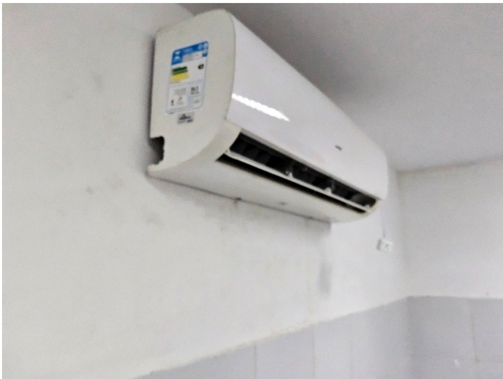
ESTRUTURA DA UNIDADE - Consultório Médico
