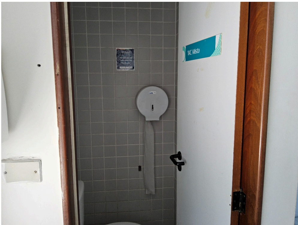
AMBIENTES E ESTRUTURA FÍSICA - Sanitários adaptados para pessoa com deficiência (PcD)
