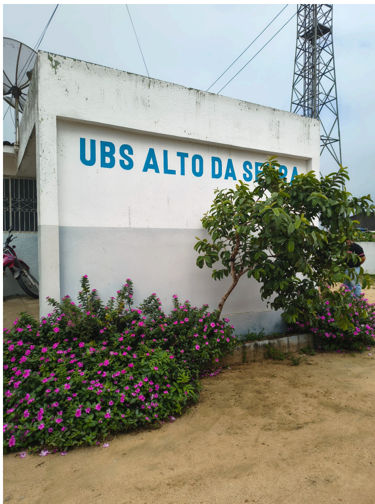
DADOS CADASTRAIS - Registro Fotográfico da Fachada
