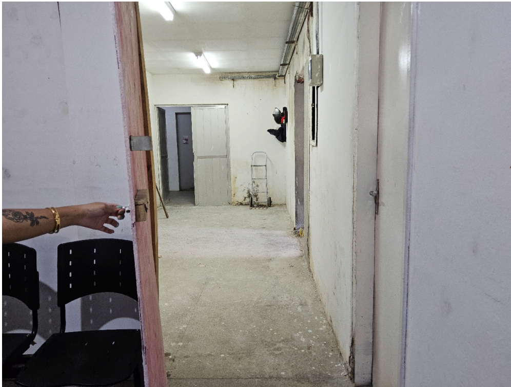
ESTRUTURA DA UNIDADE - Sala de Observação
