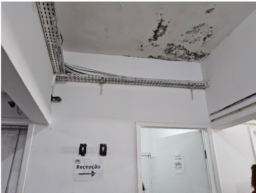
ESTRUTURA DA UNIDADE - Sala de Observação
