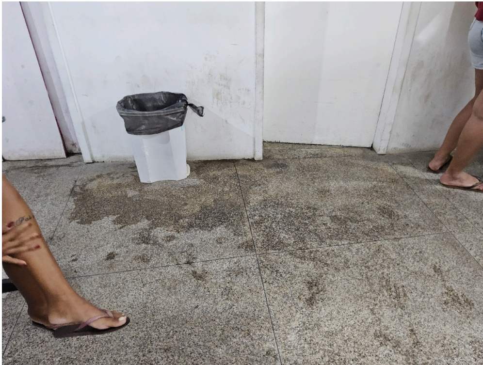
ESTRUTURA DA UNIDADE - Sala de Observação
