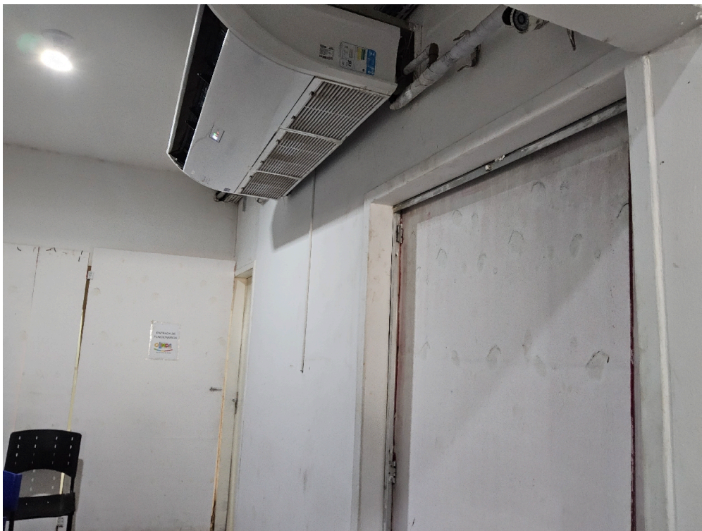
ESTRUTURA DA UNIDADE - Sala de Observação
